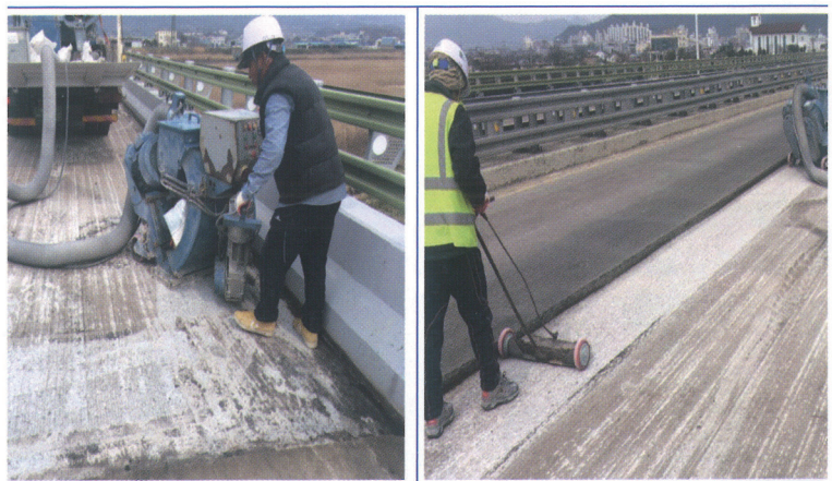
샷블라스트를 이용한 표면처리
