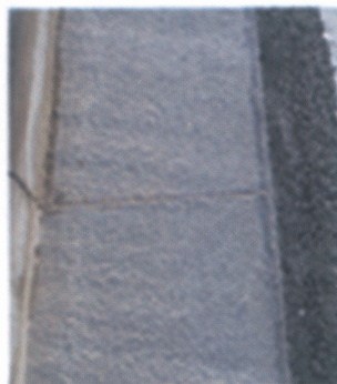
화성동탄 L형측구 시공사진
