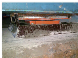
07 신규 교좌장치 무수축 콘크리트 타설
