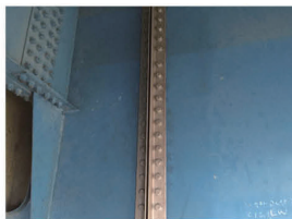
01 수직 보강제 설치완료
