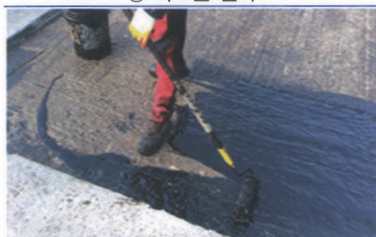
④ 수지형 유화 타르 방수제 도포
