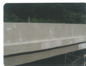
기존 구조물 시공
