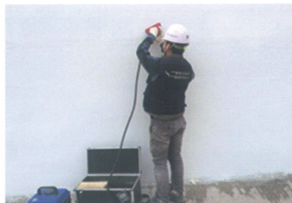
현장 부착강도 시험
