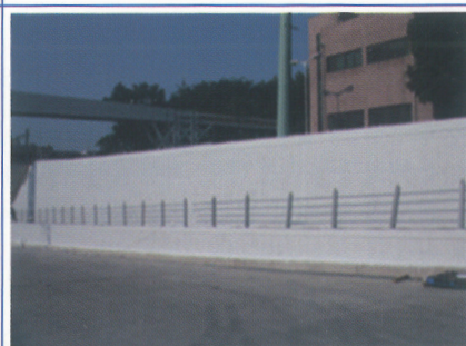
⑥ 시공 완료
