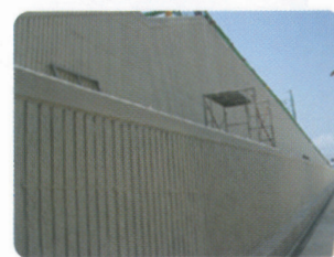
신규 구조물 시공
