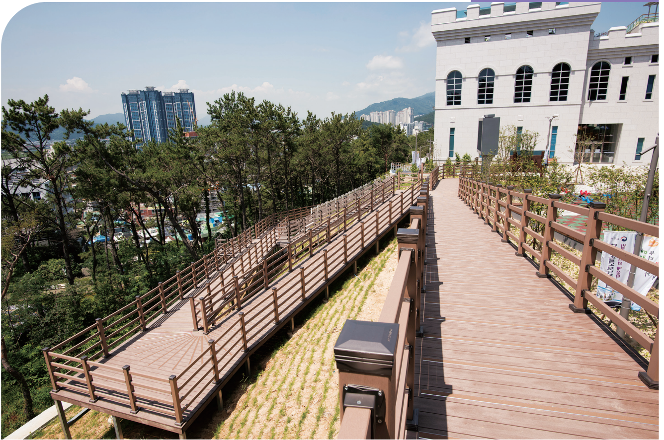
디자인형울타리 / 합성목재 시공사례
