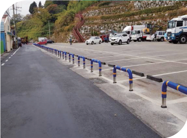
충격흡수 U볼라드 매립식 시공사례
